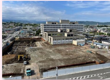
新病院の建設 (工事の進捗状況)
