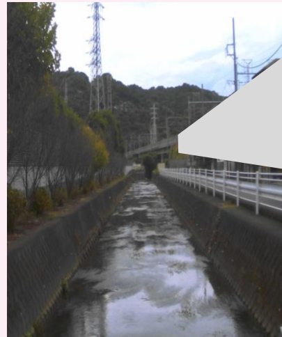
情報伝達手段の高度化 (河川氾濫災害予測システム河川カメラ映像)
